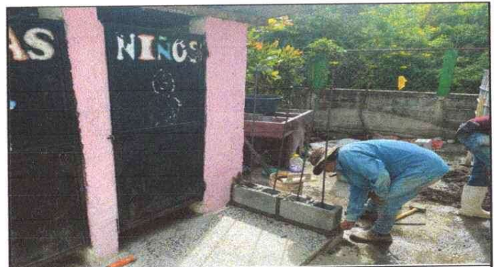
Foto 4: Remodelación de baños.
