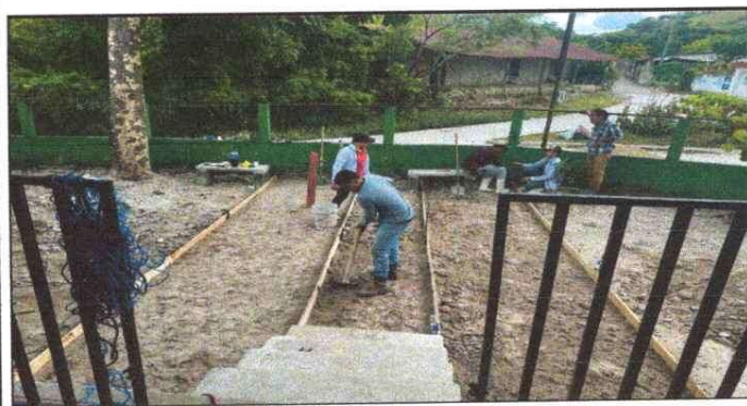
Foto 5: Reparación de banqueta y gradas de concreto.
