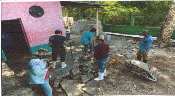
Foto 1: Sustitución de piso de torta de concreto.
