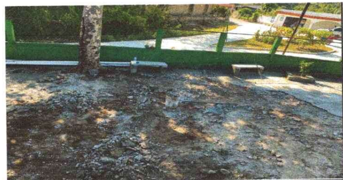
Foto 6: Sustitución de piso de torta de concreto.
