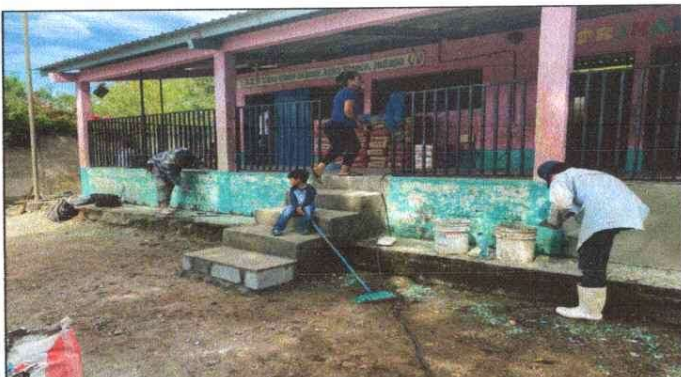
Foto 3: Reparación de banqueta y gradas de concreto
