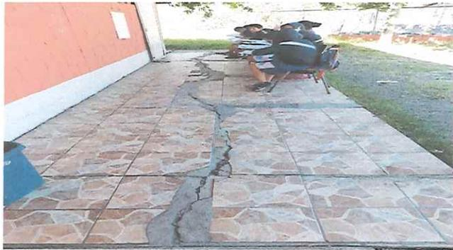
Foto 1: Piso ceramico deteriorado, se cubrira el 100% del los daños.
