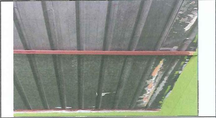
Foto1: Cambio de cubierta de lamina, en mal estado
