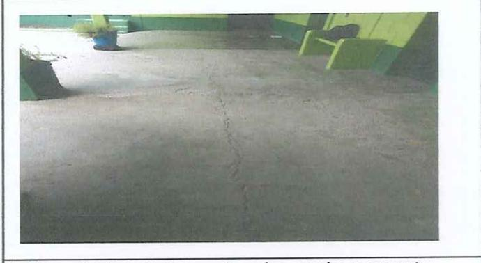
Foto 2: sustitucion torta de concreto, a piso ceramico se encuentra gretado
