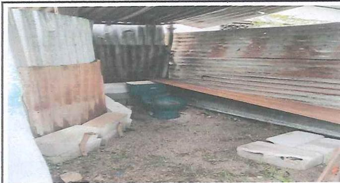
Foto 3: Baño en mal estado y circulado de lamina, cambio de sanitario, se forzara con pared de block y techo de terraza para colocar un tinaco, piso cerámico
