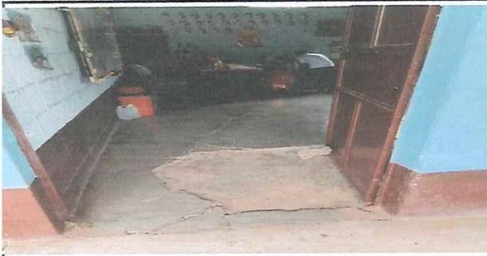
Foto 1: Remodelación de torta de cemento, se cambiara por piso cerámico
