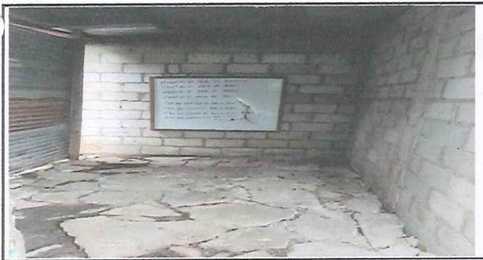
Foto 5: Remodelación de Aula, repello, sustitución de pared de block, piso cerámico, reparación del techo de lamina, puerta nueva y ventanas, para mejor ventilación
