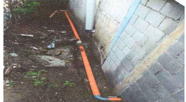
Foto 6: Reparación de tubería de drenaje y bajada de agua pluvial
