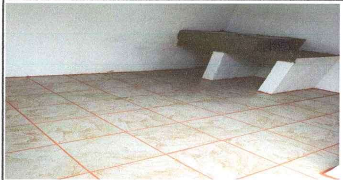
Foto 4: remodelación de cocina, colocación de piso y reparación de polletón
