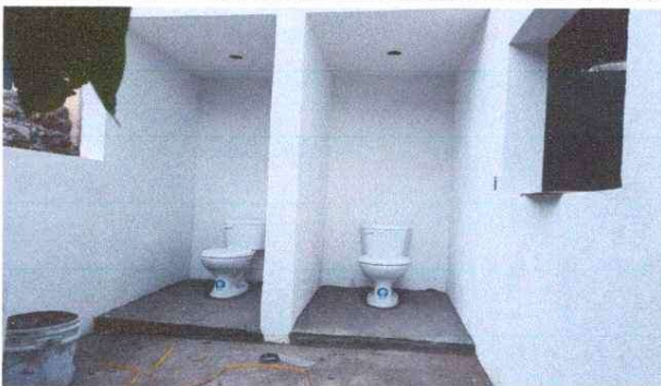
Foto 3: Remodelación de baños y sustitución de 2 inodoros
