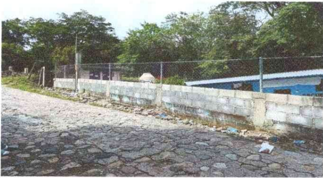
Foto1: Reparación de Muro Perimetral
