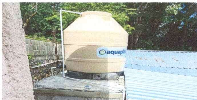
Foto 5: Instalación de tinaco
