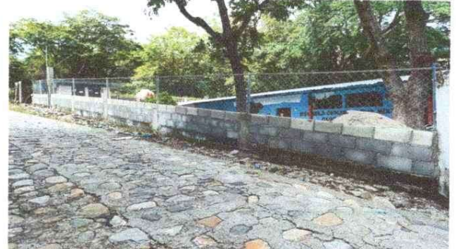
Foto 2: Reparación de Muro Perimetral
