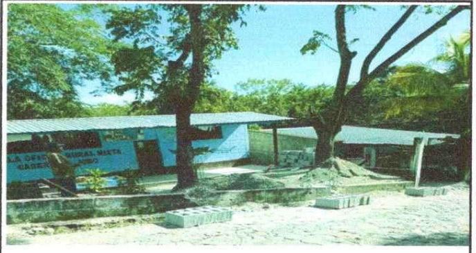
Foto 2: Reparación de Muro Perimetral en proceso
