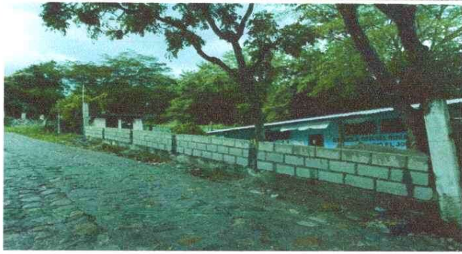
Foto 1: Reparación de Muro Perimetral en Proceso
