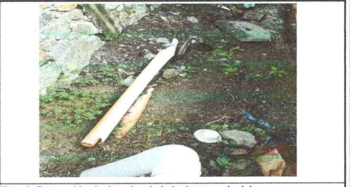
Foto 6: Reparación de drenaje y bajada de agua pluvial
