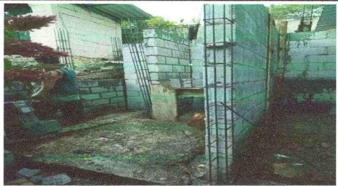
Foto 3: Reparación y remodelación de baños
