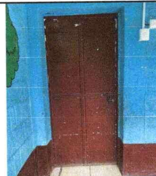
Foto 6: Reparación de puerta de aula
