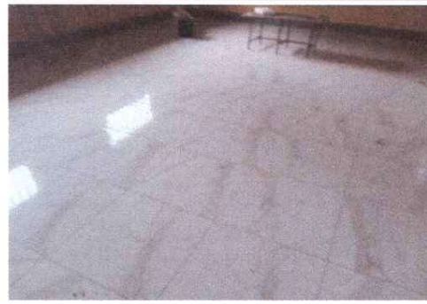
Foto 4: Las aulas ya tienen colocado el piso de porcelanato en su totalidad
