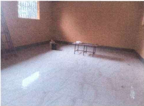
Foto 3: Las aulas ya tienen colocado el piso de porcelanato en su totalidad
