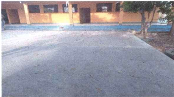
Foto 5: El pavimento ya finalizado
