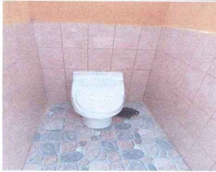
Foto 1: El sanitario uno ya finalizado, nuevo, con azulejo, piso, y pintado, techo nuevo
