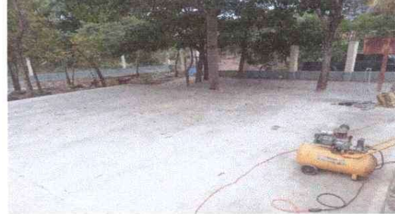
Foto 6: El pavimento ya finalizado
