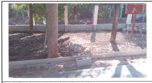
Foto 6: El patio en proceso de pavimentacion
