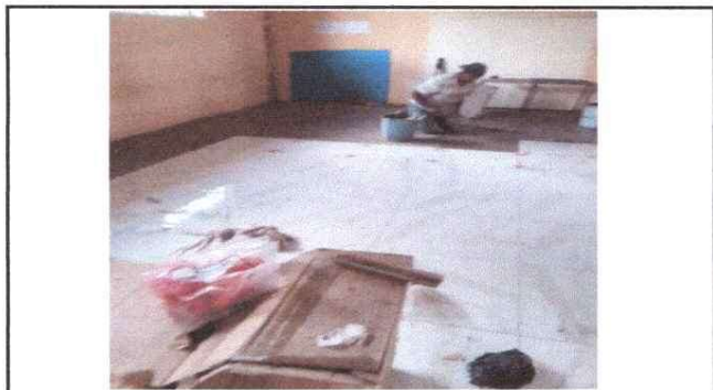
Foto 4: Las aulas en su colocacion de piso porcelanato
