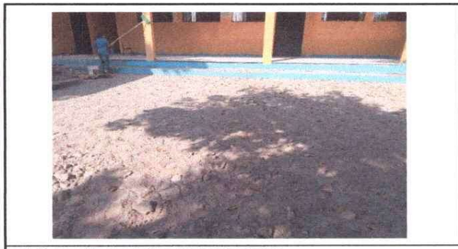
Foto 5: El patio en proceso de pavimentacion
