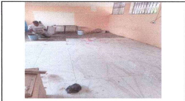
Foto 3: Las aulas en su colocacion de piso porcelanato
