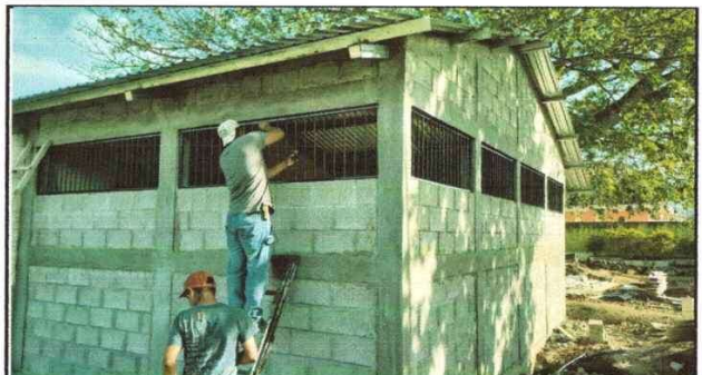
Foto 4: Instalación de balcones en la reparación de la cocina
