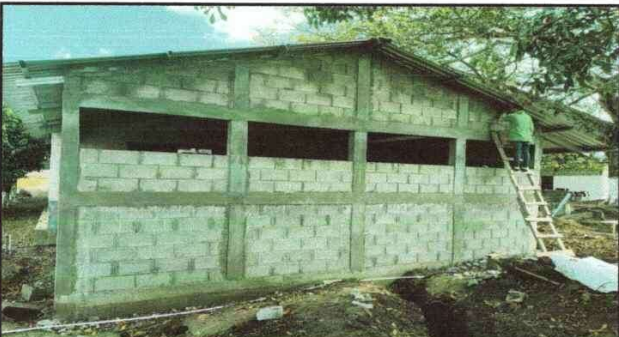
Foto 3: Tallado de columnas para la reparación de la cocina
