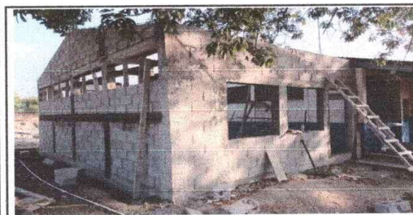
Foto 5: finalización de levantado de pared para reparación de la cocina
