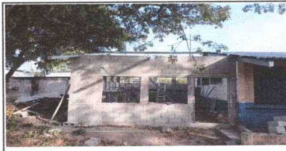
Foto 6: Instalación de estructura de soporte de metal para reparación de la cocina
