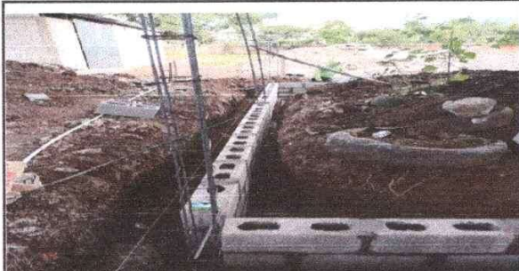
Foto 1: Fundición de arranques para la reparación de la cocina
