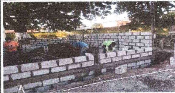
Foto 2: pegado de block para levantado de pared para reparación de la cocina
