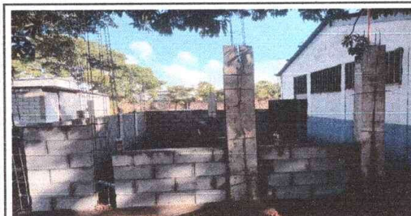
Foto 3: Fundición de las primeras columnas para reparación de la cocina
