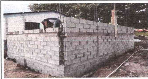
Foto 4: Levantado de pared para reparación de la cocina
