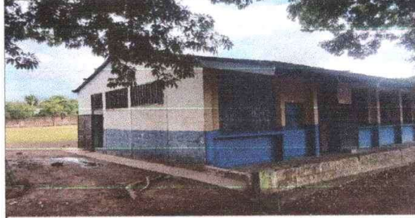
Foto 2: Pared que fortalecerá la ampliación de cocina
