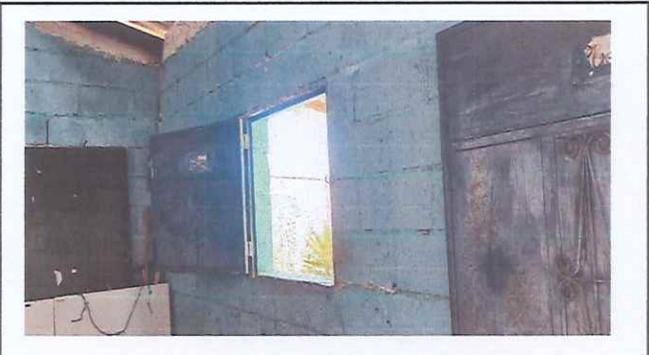
Foto 4: Ventana en mal estado se les dará mantenimiento.
