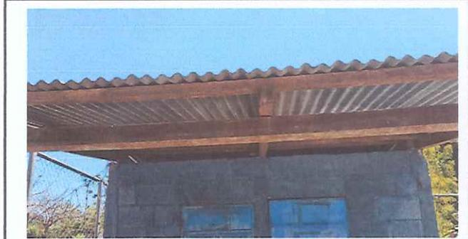
Foto 1: Techo de baños en mal estado, se sustituirá
