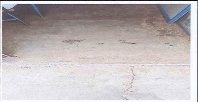
Foto 6: Piso en mal estado, se sustituirá por piso cerámico
