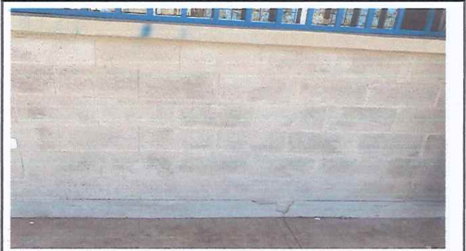
Foto 4: Pintura de paredes interiores y exteriores
