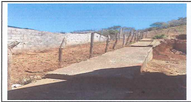
Foto 5: Cerco de alambre de pua en mal estado
