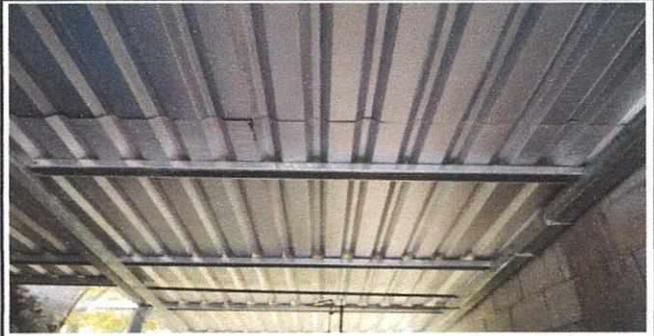
Foto 2: colocacion de lamina troquelada, e instalacion de soporte de metal tubos de 3x3 y costanera
