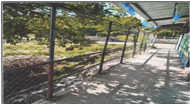
Foto 1: MEJORAMIENTO DE BARANDA COLOCACION DE TUBO Y MALLA GALVANIZADA CON PUERTA DE INGRESO
