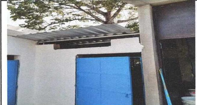
Foto 4: fabricacion e instalacion de puerta de ingreso a baños y bodega asi mismo terraza de los baños para colocar tinaco para el agua.
