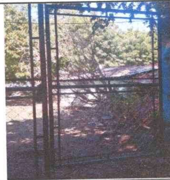
Foto 2: Mejoramiento de porton.
