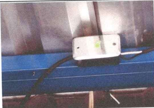
Foto 1: Mejoramiento del sistema electrico.
