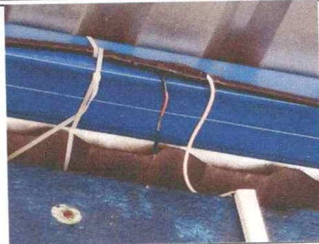
Foto 2: Mejoramiento del sistema electrico.
