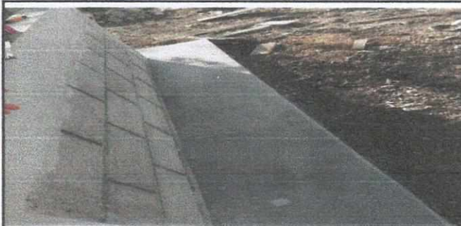
Foto 5: Mejoramiento y ampliación de área de sanitarios con pasamanos de block y banquetas .
