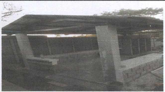
Foto 3: Sustitución de techo de servicios sanitarios y ampliación para área de recepción de alimentos .
