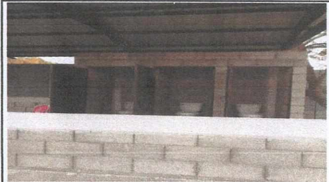
Foto 2: Mejoramiento de servicios sanitarios.
