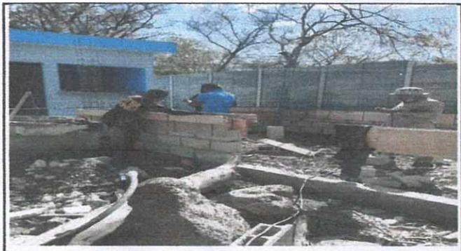
Foto 4: Mejoramiento de área de sanitarios con pasamanos de block .
