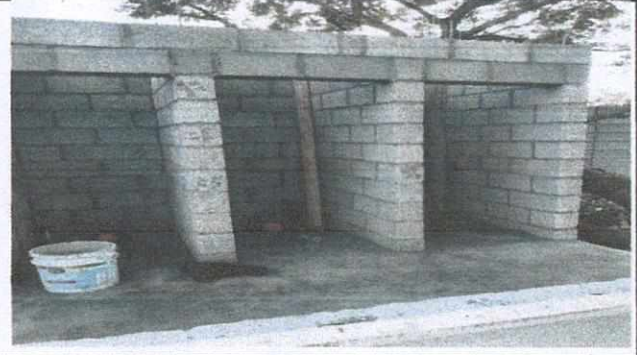
Foto 2: Mejoramiento de servicios Sanitarios.
