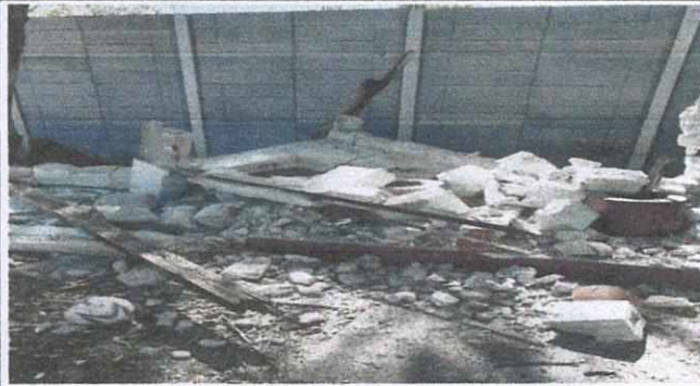
Foto 1: Mejoramiento de servicios Sanitarios.
