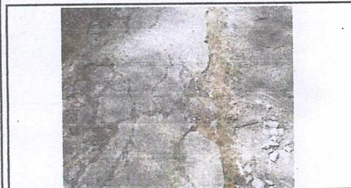
Foto 5: Ingreso a aulas en mal estado.
