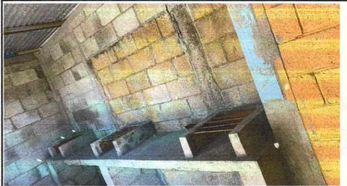
Foto 4: Remozamiento de poyetón y hornillas en área de cocina.
