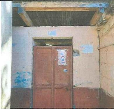
Foto 3: Baños en mal estado, se presenta separacion en las paredes por falta de columnas.
