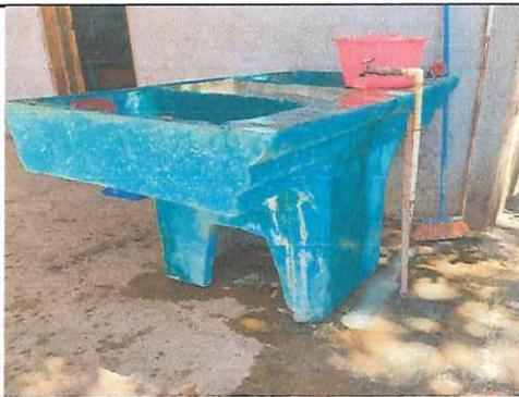
Foto 5: falta de drenaje que conecte con la fosa
