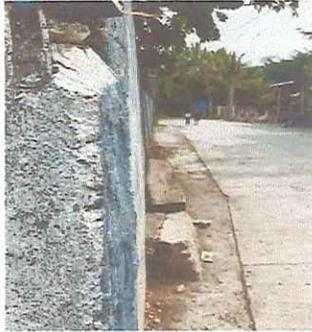
Foto 1: MURO PERIMETRAL DESPLOMADO, SE DEMOLERA Y SE REPARARA EL CIMIENTO, POSTERIOR A ESO SE COLOCARA MURO PREFABRICADO TIPO LADRIBARDA
