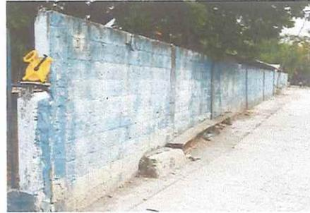
Foto 2: MURO PERIMETRAL DESPLOMADO, SE DEMOLERA Y SE REPARARA EL CIMIENTO, POSTERIOR A ESO SE COLOCARA MURO PREFABRICADO TIPO LADRIBARDA
