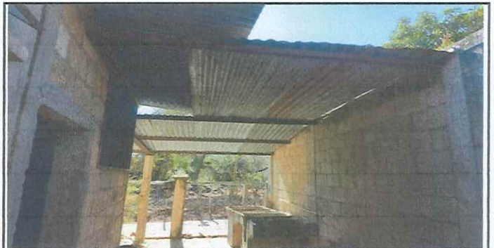
Foto 6: Área de cocina se mejorará con una pared de blok y losa fundida con columnas, se instalara un tinaco, se repellarán y pintarán las paredes
