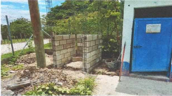
Foto 3: Ampliación y remozamiento de los baños
