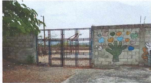
Foto: 4 Reparación del portón posterior del establecimiento.
