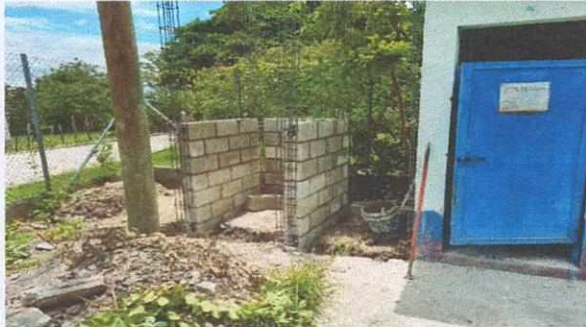
Foto 3: Ampliación y remozamiento de los baños
