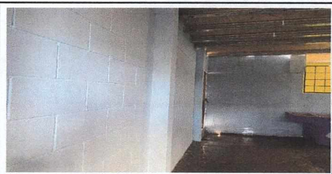
Foto 6: Área de cocina restituida en pared lado sur
