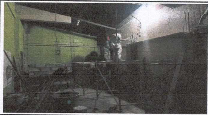
Foto 2: Formaleta de Viga para soporte de techo de cocina
