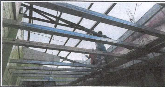
Foto 5: Demontaje de techo superior de cocina
