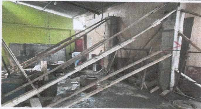
Foto 1: Reforzamiento de pared lateral lado oeste de Cocina con columnas
