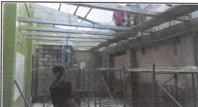
Foto 4: Preparación y nivelación de costanera para piso de entretecho almacén de cocina
