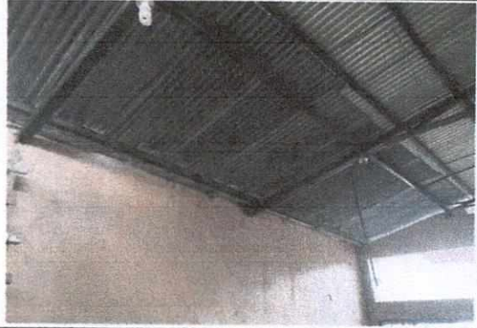
Foto 2: Sustitución de techo del área de cocina
