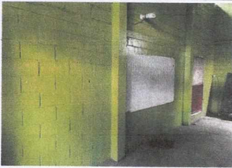
Foto 5: Reparación de aula
