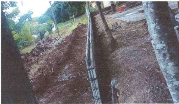
Continuación de Muro Perimetral del Establecimiento
