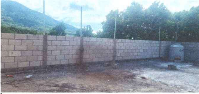
Levantado de Muro Colocación de Tubo en la Parte de la Terraza del Establecimiento
