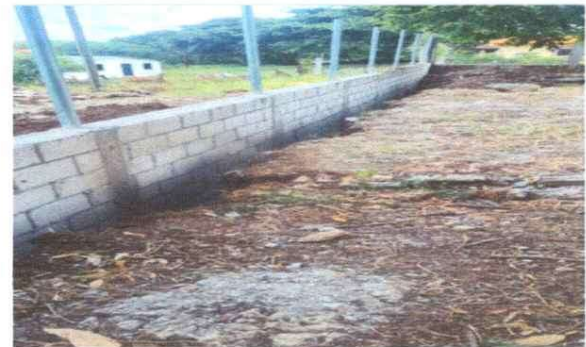
Colocación de Tubos en Muro Perimetral
