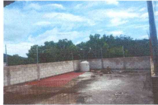
Aplicación de Impermibilizante en la parte de la Terraza del Establecimiento
