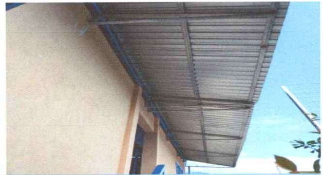
Cubierta de Lamina con Estructura Metalica en la Parte del Salon del Establecimiento
