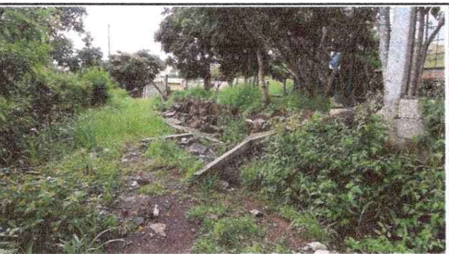
Foto 5: Se remozará el área con levantado de paredes y cierre perimetral.
