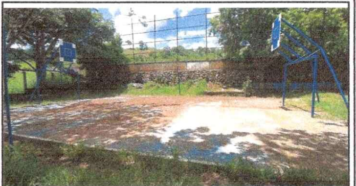
Foto 4: Mejoramiento de cancha fundiendo 7.5 cm de concreto para mejorar la altura.
