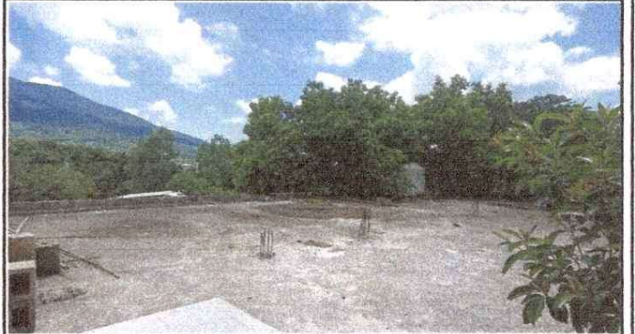
Foto 2: Mejoramiento de terraza levantando un muro de tres block de altura.
