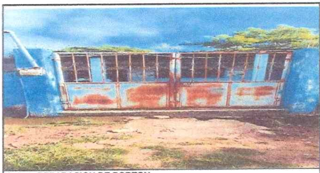
Foto 5: REPARACION DE PORTON
