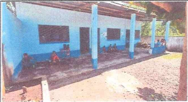
Foto 1: REPARACION DE PISO
