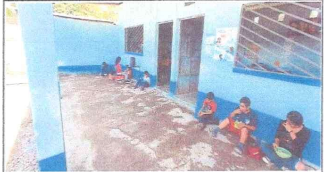
Foto 2: REPARACION DE PISO
