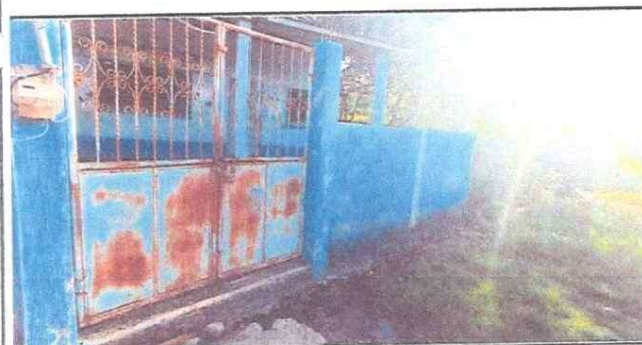
Foto 5: PINTURA DE MUROS EXTERIORES E INTERIORES
