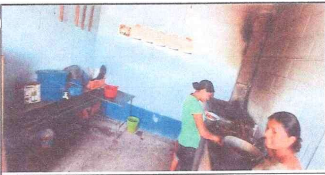
Foto 5: REPARACION DE COCINA
