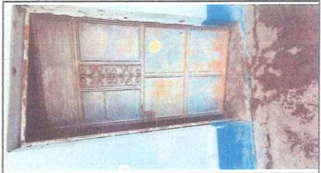
Foto 2: PUERTAS DE METAL
