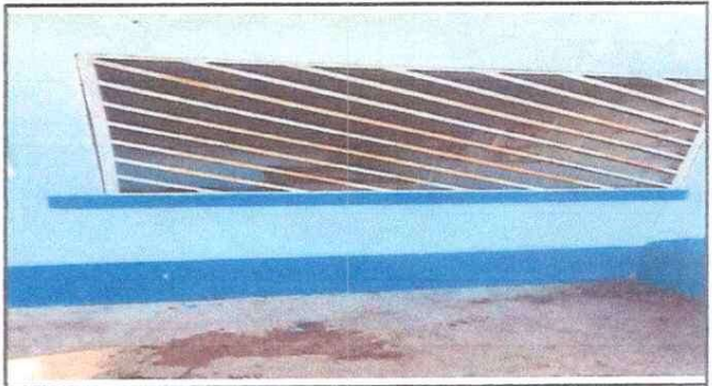
Foto 4: REPARACION DE BALCONES
