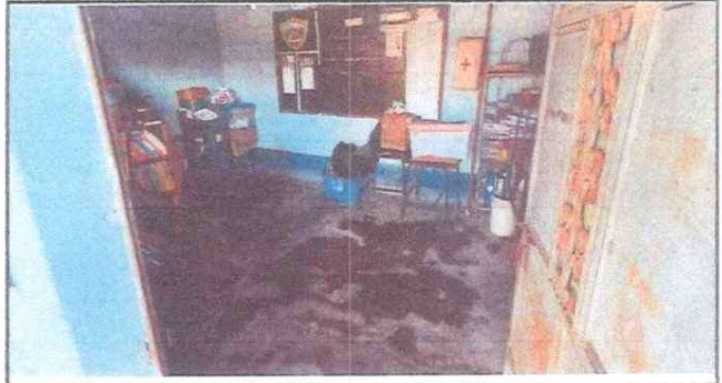
Foto 4: REPARACION DE PISO
