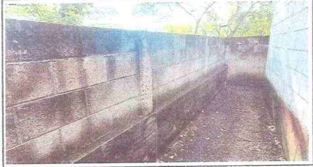
Foto 2: REPARACION DE MUROS DE CONTENCIÓN
