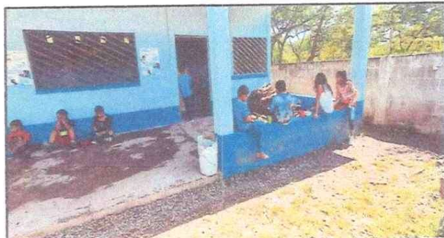
Foto 4: PINTURA DE MUROS EXTERIORES E INTERIORES
