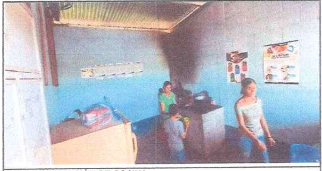
Foto 6: REPARACION DE COCINA
