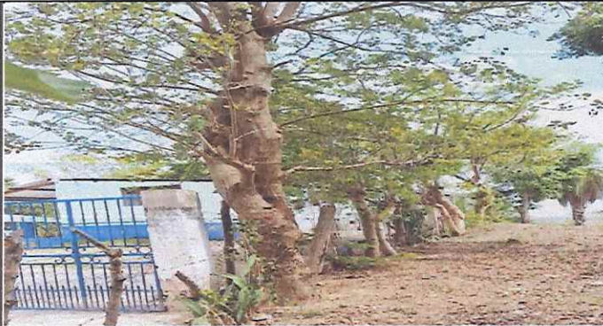
Foto 3: Mejoramiento de muro con 2 hiladas de block y tubo a un costado del Centro Educativo.
