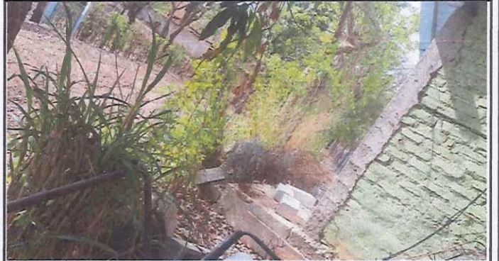
Foto 4: Mejoramiento de muro con maya a un costado del Centro Educativo, con tubo en la parte alta de la maya.
