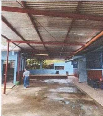
Foto 3: SUSTITUCIÓN TECHO CON ESTRUCTURA DE METAL POR LÁMINA TROQUELADA EN PATIO
