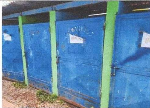
Foto 6: MANTENIMIENTO A ESTRUCTURA (LIJADO, CAMBIO DE TUBO , CEPILLADO, SUJECIONES, APLICACIÓN DE PINTURA) EN PUERTAS
