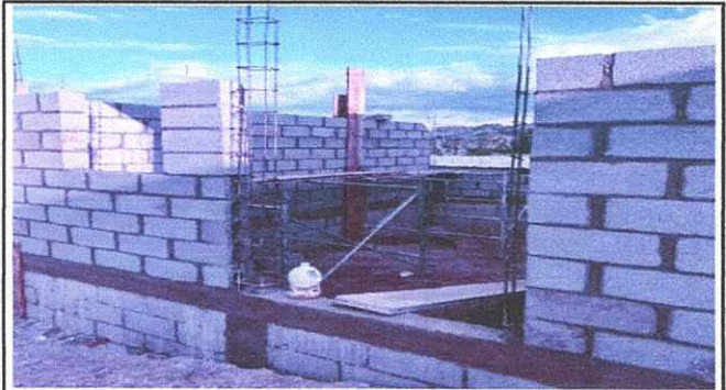
Foto 2: area de mejoramiento para cocina
