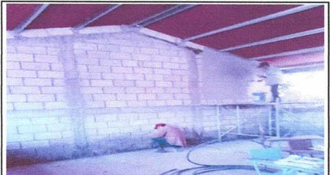
Foto 4: mejoramiento de ventanas y paredes del aula
