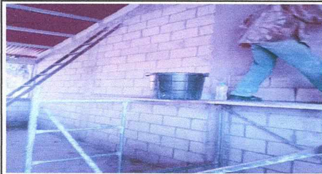
Foto 3: Mejoramiento de paredes y piso de aula
