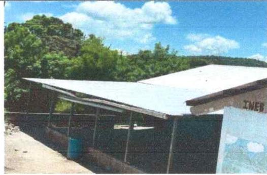
Foto 2: MEJORAMIENTO DE TECHO CON ESTRUCTURA METALICA Y LAMINA TROQUELADA
