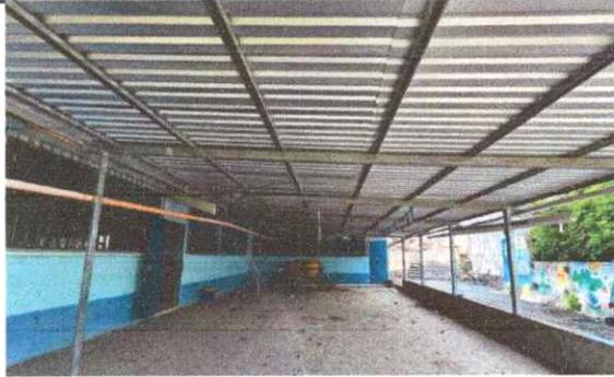
Foto 1: MEJORAMIENTO DE TECHO CON ESTRUCTURA METALICA Y LAMINA TROQUELADA
