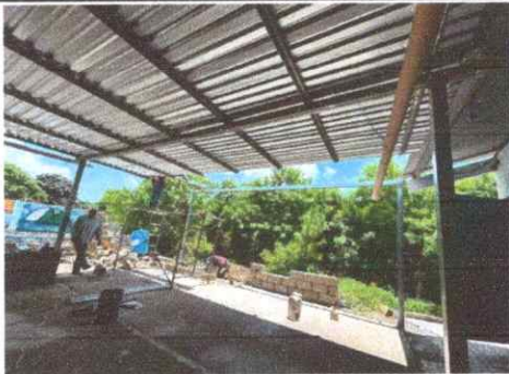
Foto 1: MEJORAMIENTO DE TECHO CON ESTRUCTURA METALICA Y LAMINA TROQUELADA
