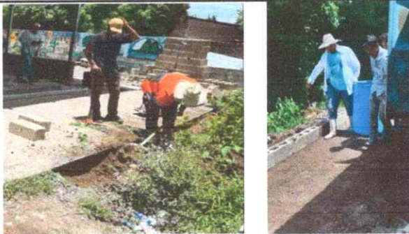
Foto 5: REPARACIÓN DE TORTA DE CONCRETO
