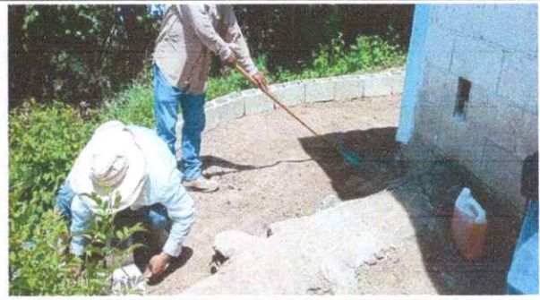
Foto 6: REPARACIÓN DE TORTA DE CONCRETO
