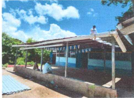
Foto 2: MEJORAMIENTO DE TECHO CON ESTRUCTURA METALICA Y LAMINA TROQUELADA
