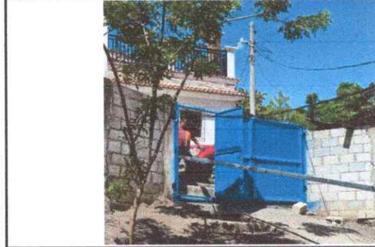
Foto 8: REPARACIÓN Y PINTURA GENERAL EN PORTÓN METALICO
