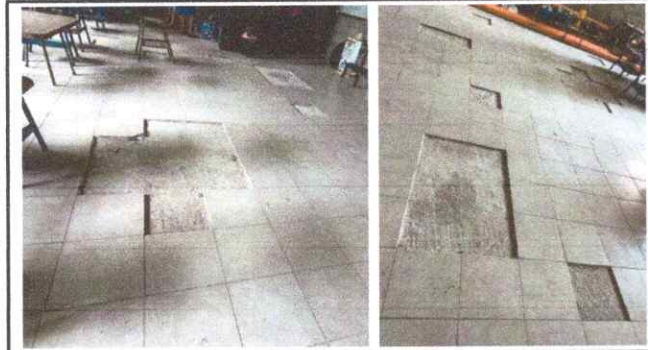
Foto 7: REPARACIÓN DE PISO CERAMICO
