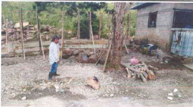
Foto 3: MEJORAMIENTO DE MURO DE CONTENCIÓN
