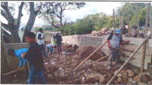
Foto 5: MEJORAMIENTO DE MURO DE CONTENCIÓN
