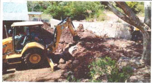
Foto 2: MEJORAMIENTO DE MURO DE CONTENCIÓN
