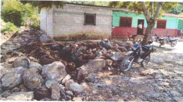
Foto 1: MEJORAMIENTO DE MURO DE CONTENCIÓN
