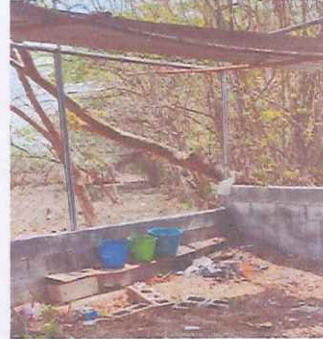
Foto 2: Instalación de techo con estructura metalica y lamina troquelada
