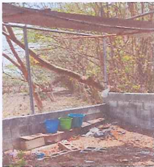
Foto 3: Colocación de piso de granito
