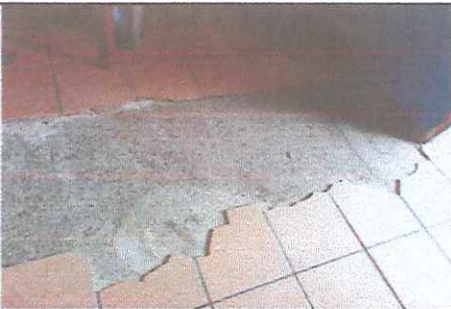
Foto 5: Sustitución de Piso en aula
