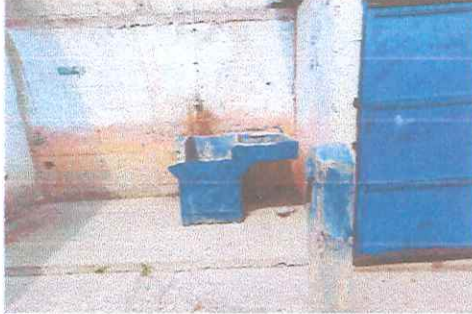
Foto 1: Repello de paredes de baños
