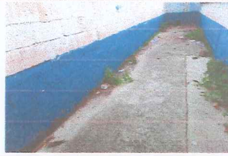
Foto 2: Ampliación de Bodega
