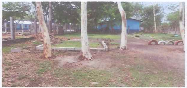
Foto 4: Remozamiento de aula.
