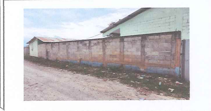
Foto1: Muro exterior del establecimiento para pintar
