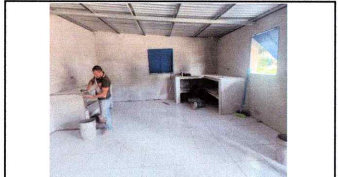
Foto 8: SUSTITUCIÓN DE TORTA DE CONCRETO POR PISO CERAMICO
