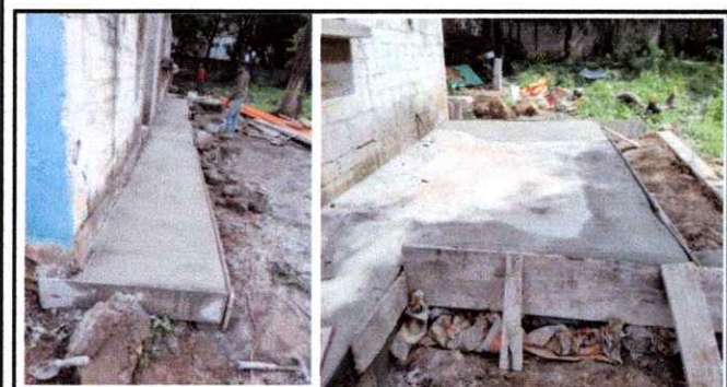
Foto 3: REPARACIÓN DE BANQUETA DE CONCRETO
