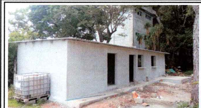
Foto1: SUSTITUCIÓN DE TECHO CON ESTRUCTURA DE METAL POR LÁMINA TROQUELADA
