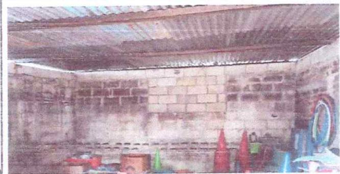
Foto 1: SUSTITUCION DE TECHO CON ESTRUCTURA METALICA Y LAMINA TROQUELADA
