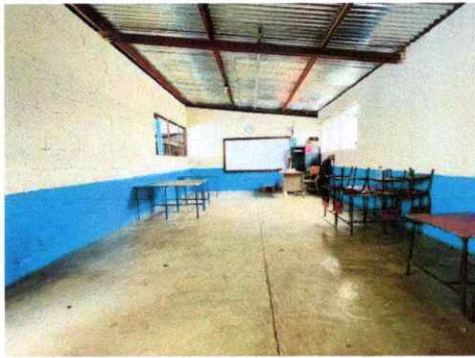
Foto 7: PINTURA EN MUROS INTERIORES Y EXTERIORES
