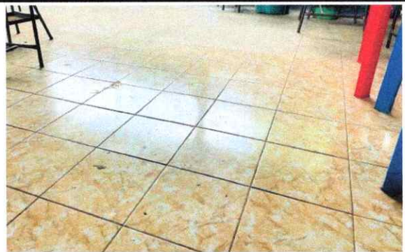
Foto 10: SUSTITUCIÓN DE TORTA DE CONCRETO POR PISO CERÁMICO
