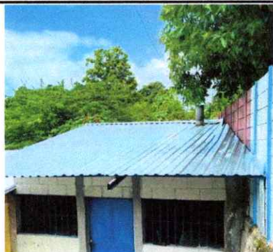
Foto 1: INSTALACIÓN DE TECHO CON ESTRUCTURA METALICA Y LAMINA TROQUELADA EN COCINA
