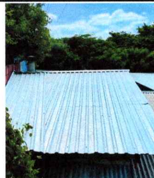
Foto 2: INSTALACIÓN DE TECHO CON ESTRUCTURA METALICA Y LAMINA TROQUELADA EN COCINA
