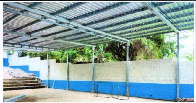
Foto 12: INSTALACIÓN DE TECHO CON ESTRUCTURA METÁLICA Y LAMINA ACANALADA
