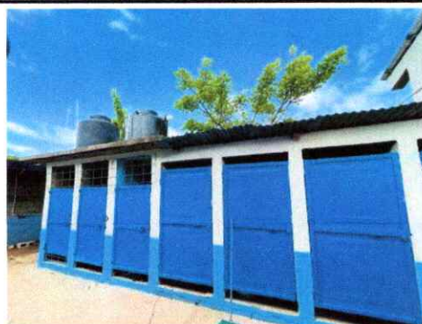
Foto 3: INSTALACIÓN DE TUBERÍA PARA DEPÓSITO DE AGUADEY MEJORAMIENTO DE FOSAS SÉPTICAS
