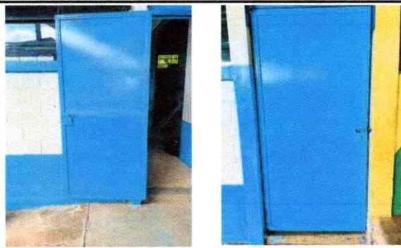
Foto 6: REPARACIÓN, PINTURA GENERAL E INSTALACIÓN DE CHAPA EN PUERTAS METALICAS
