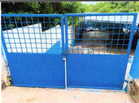
Foto 11: MEJORAMIENTO DE PORTÓN DE ACCESO PRINCIPAL
