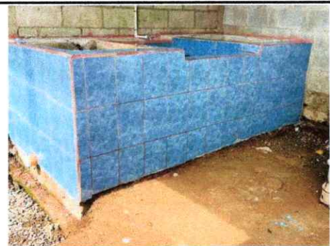
Foto 5: MEJORAMIENTO E INSTALACIÓN DE AZULEJO EN PILA EXISTENTE
