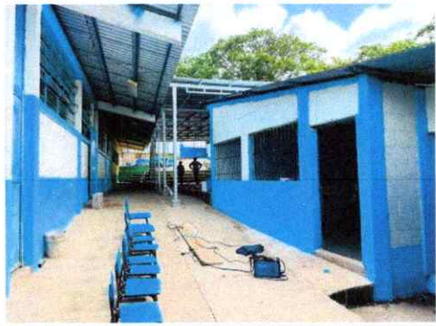
Foto 8: PINTURA EN MUROS INTERIORES Y EXTERIORES
