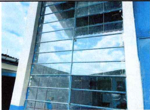
Foto 9: INSTALACIÓN DE VIDRIOS
