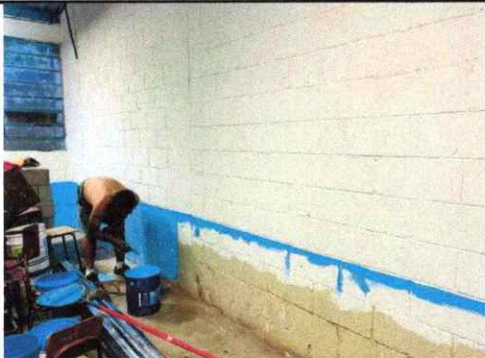
Foto 7: PINTURA EN MUROS INTERIORES Y EXTERIORES
