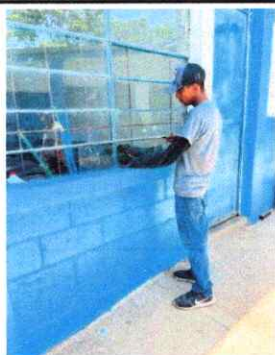
Foto 9: INSTALACIÓN DE VIDRIOS
