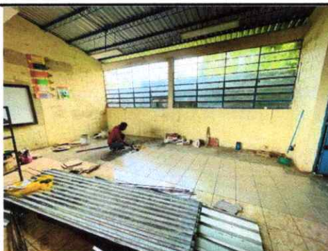
Foto 10: SUSTITUCIÓN DE TORTA DE CONCRETO POR PISO CERÁMICO
