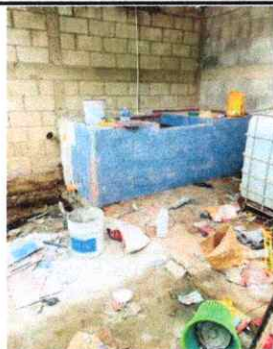
Foto 5: MEJORAMIENTO E INSTALACIÓN DE AZULEJO EN PILA EXISTENTE
