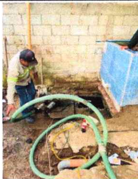
Foto 3: LIMPIEZA Y MEJORAMIENTO DE FOSAS SÉPTICAS
