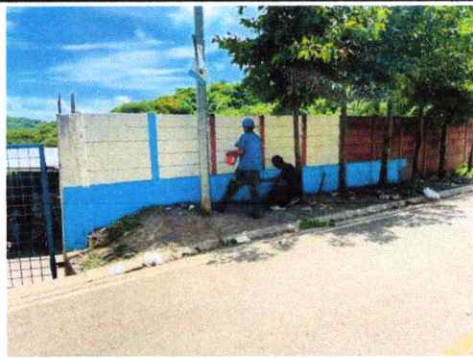
Foto 8: PINTURA EN MUROS INTERIORES Y EXTERIORES
