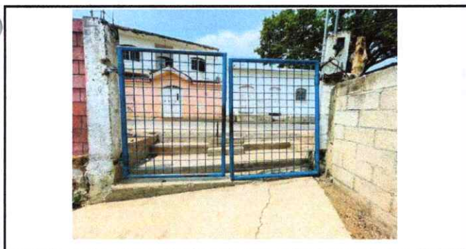
Foto 11: MEJORAMIENTO DE PORTÓN DE ACCESO PRINCIPAL
