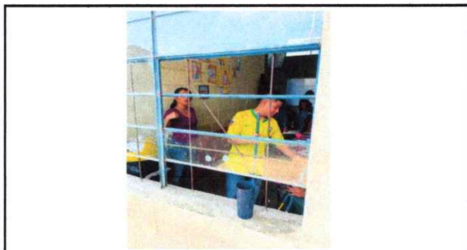
Foto 9: INSTALACIÓN DE VIDRIOS
