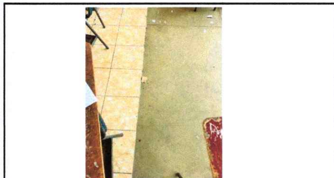
Foto 10: SUSTITUCIÓN DE TORTA DE CONCRETO POR PISO CERÁMICO
