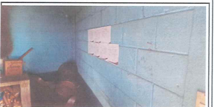
Foto 6. área de aperturará ventana e instalación de balcón
