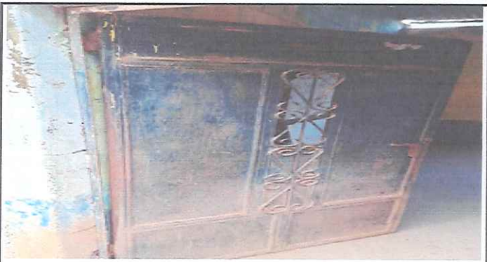
Foto 3. Sustitución de puerta de metal
