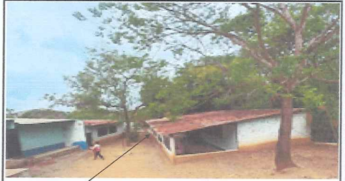
Foto 8. Instalación de canal
