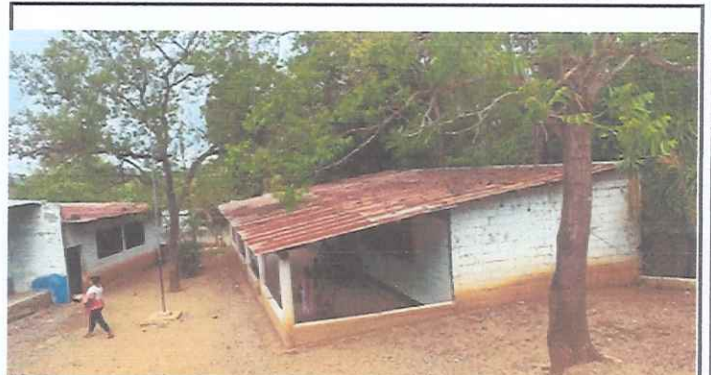
Foto 2. Instalación de techo
