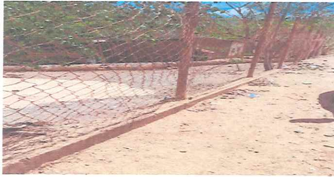
Foto 7. Mejoramiento de muro de maya
