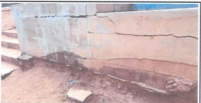
Foto 5. Reparación de muro de banqueta
