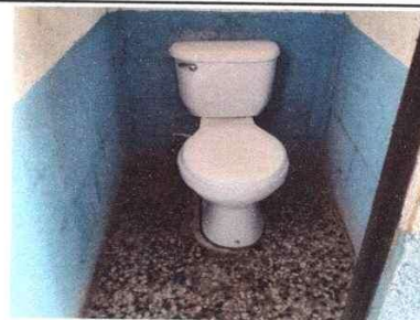
Foto 4: MEJORAMIENTO DE INODOROS
