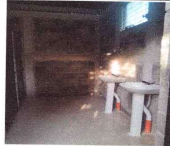
Foto 2: INSTALACIÓN DE PUERTA, VENTANA, PISO EN BAÑOS
