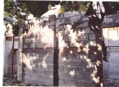
Foto 2: SUSTITUCIÓN Y LEVANTAMIENTO DE BLOCK EN MÓDULO DE BAÑOS
