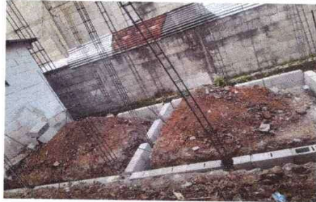
Foto 1: MEJORAMIENTO Y AMPLIACIÓN DE MÓDULO DE SERVICIOS SANITARIOS
