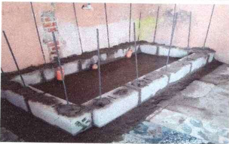
Foto 3: SUSTITUCIÓN Y FUNDICIÓN DE PILA DE 2 LAVADEROS
