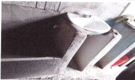
Foto 5: REMOZAMIENTO DE MIGNITORIOS
