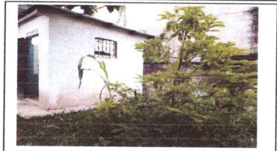
Foto 2: REMOZAMIENTO EN PARED DE BLOCK E INODOROS, MINGITORIOS Y LAVAMANOS
