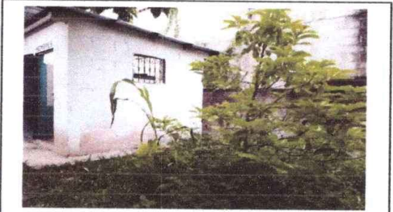
Foto 3: INSTALACIÓN DE PUERTA, VENTANA, PISO EN BAÑOS
