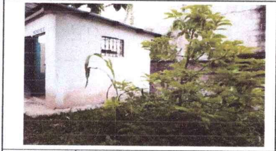
Foto1: INSTALACIÓN DE TECHO CON ESTRUCTURA METALICA Y LAMINA TROQUELADA
