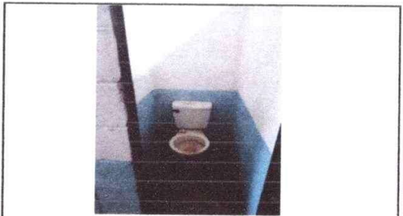
Foto 4: MEJORAMIENTO DE INODOROS
